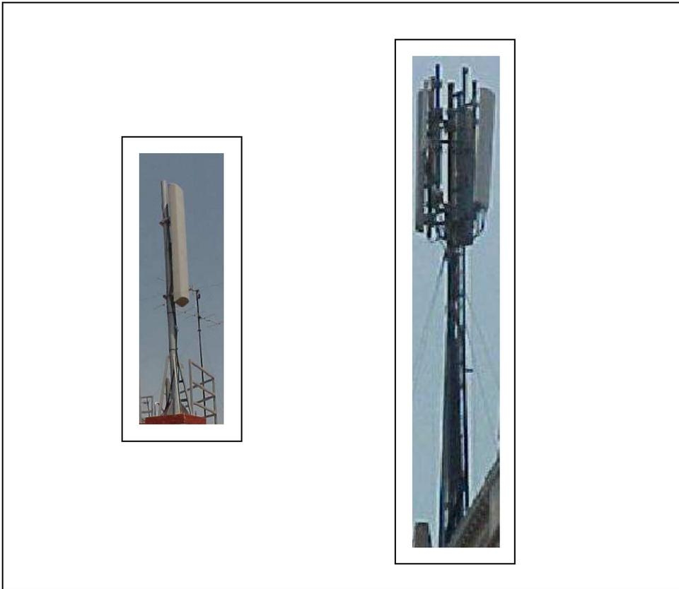
Estructura mástiles distribuidos (un mástil por antena) y estructura monomástil.
