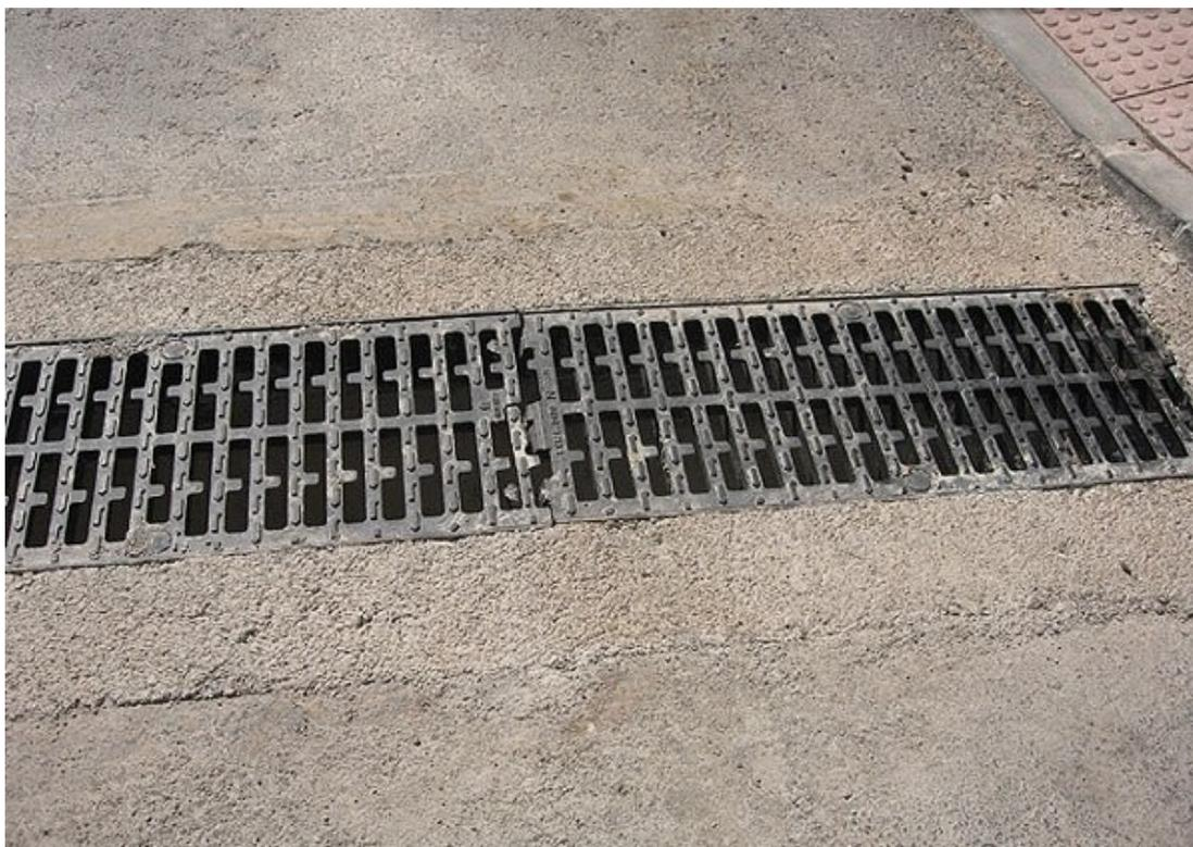
*Foto 3. Imagen de una rejilla un poco más adecuada para las bicicletas que las existentes actualmente. Lo ideal sería que estuviese dispuesta transversalmente al tráfico.*
