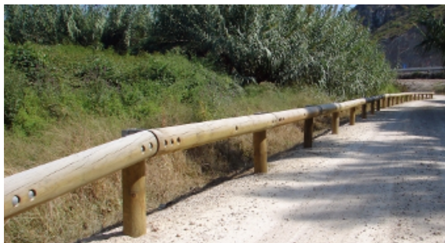
Ejemplo de bionda para delimitar el acceso.
