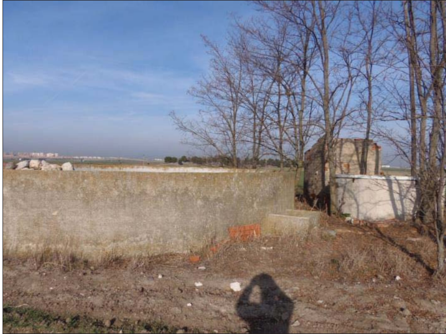
Pozo situado en el interior de la zona de actuación. Alberca a restaurar
